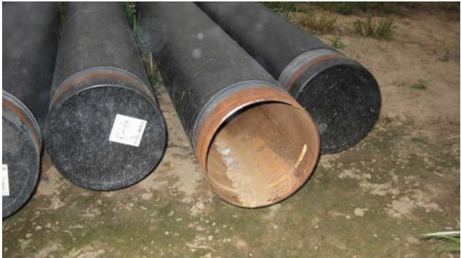
gelagerte Rohre mit und ohne Schutzdeckel
