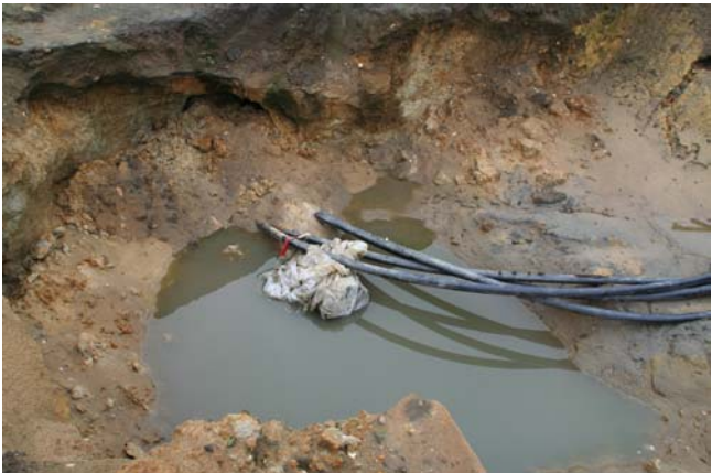
Ende eines Pipelineabschnitts liegt für Monate im Wasser
