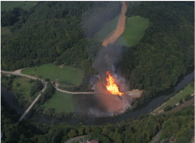
Foto: Polizei Hessen West Explosion einer Pipeline bei Limburg
