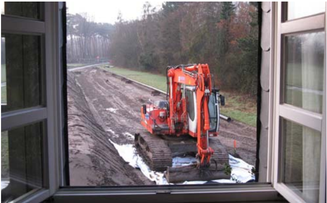
Blick aus Wohnhaus auf Pipelinebaustelle
